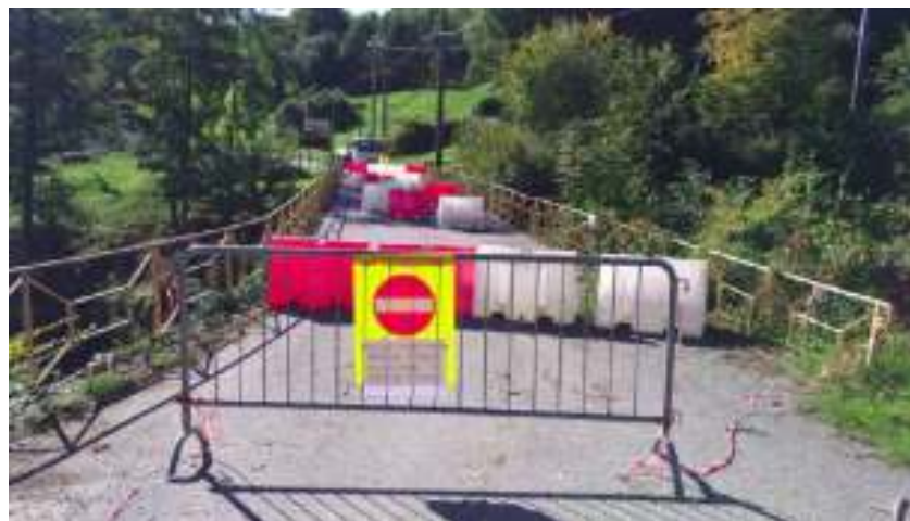
Nella fotografia a sinistra via Matteotti appena asfaltata, a fianco il ponte di frazione Valle chiuso al traffico
